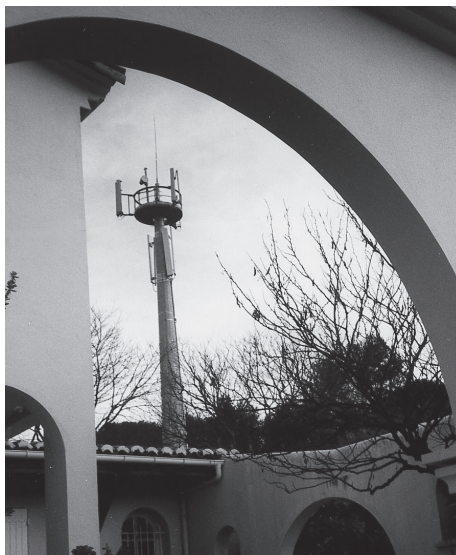
Nîmes, Gard, pylone de 20 mètres de hauteur, à 17 mètres d'une habitation
