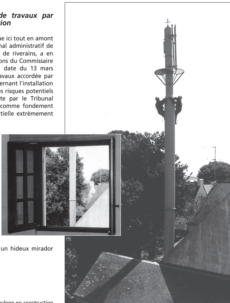
Ile aux Moines, 1999, le pylône en construction
